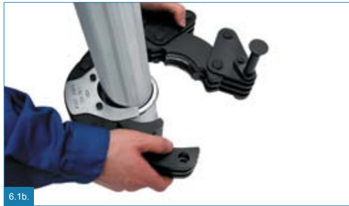
6.1b. Presavimo žnyplių uždėjimas ant fasoninės detalės
