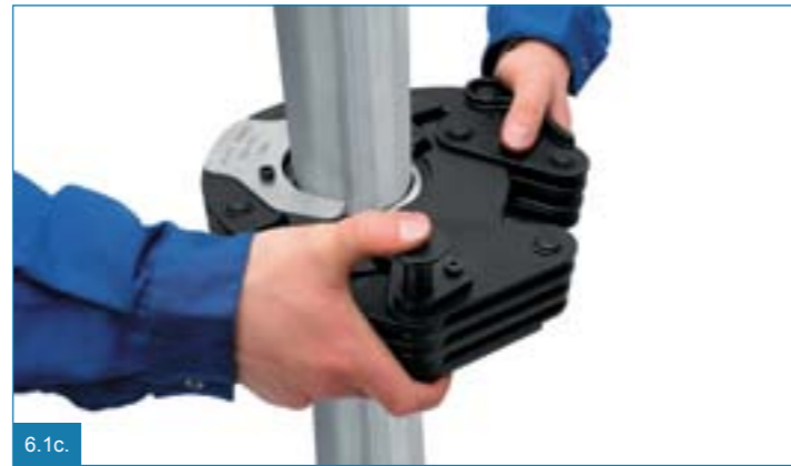
6.1c. Presavimo žnyplių fiksavimas ant fasoninės detalės
