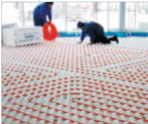
Grindinis šildymas, įvykdytas šlapiu būdu – šildantys vamzdžiai užmonolitinti grindyse
