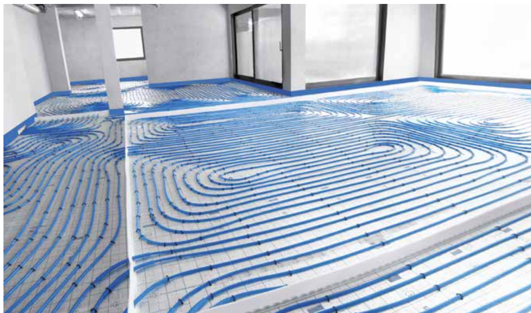
Pav. 24. KAN-therm Tacker grindinio šildymo sistema
