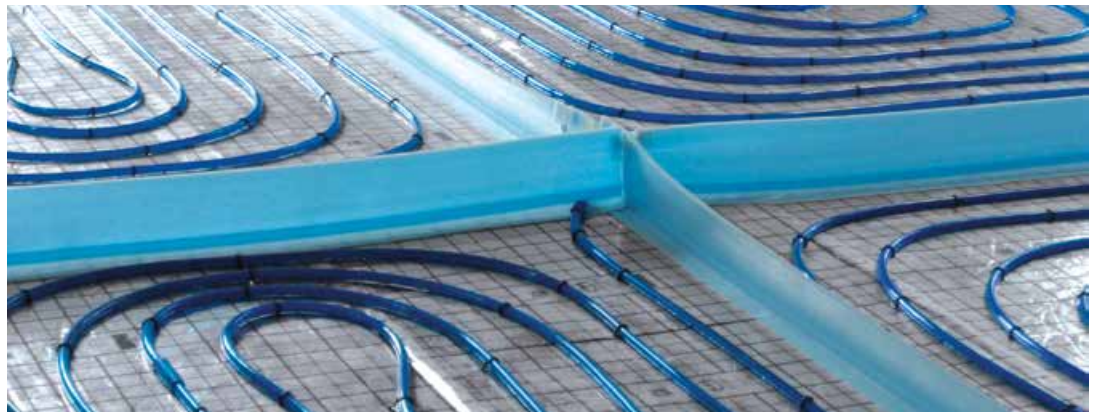
Pav. 13. Šildymo laukų suskirstymas kompensacinėmis siūlėmis
