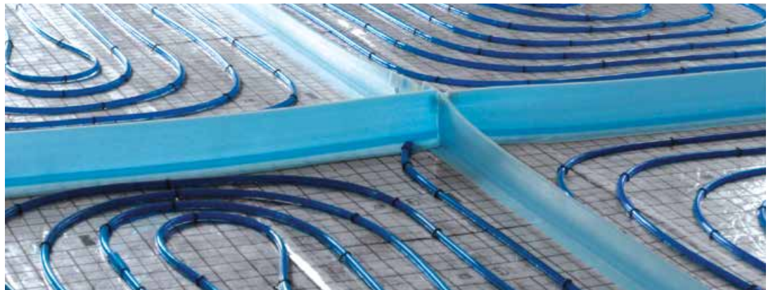
Pav. 13. Šildymo laukų suskirstymas kompensacinėmis siūlėmis
