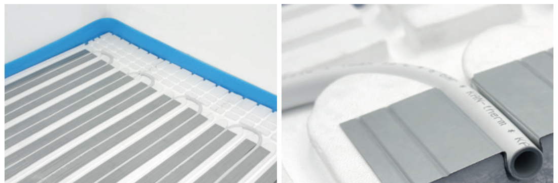
Pav. 36. KAN-therm TBS 14 plokštė su plieninėmis spinduliavimo plokštelėmis
