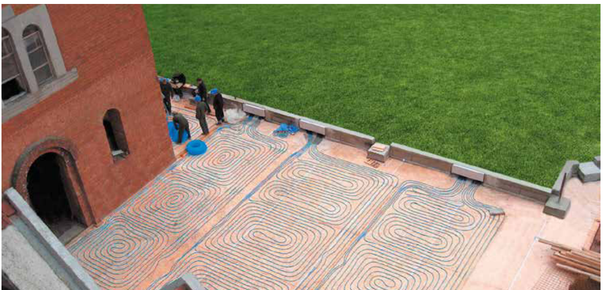
Pav. 5. Lauko terasos šildymo sistema naudojant KAN-therm sistemos bluePERT vamzdžius.
