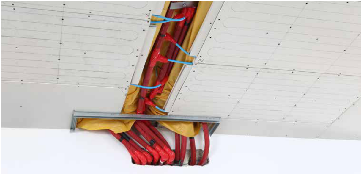
Pav. 6. Lubų vėsinimo sistema naudojant KAN-therm Wall sistemos šildymo ir vėsinimo plokštes.
