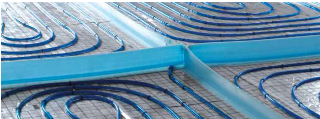
Pav. 14. Šildymo paviršiaus suskirstymas kompensacinėmis siūlėmis
