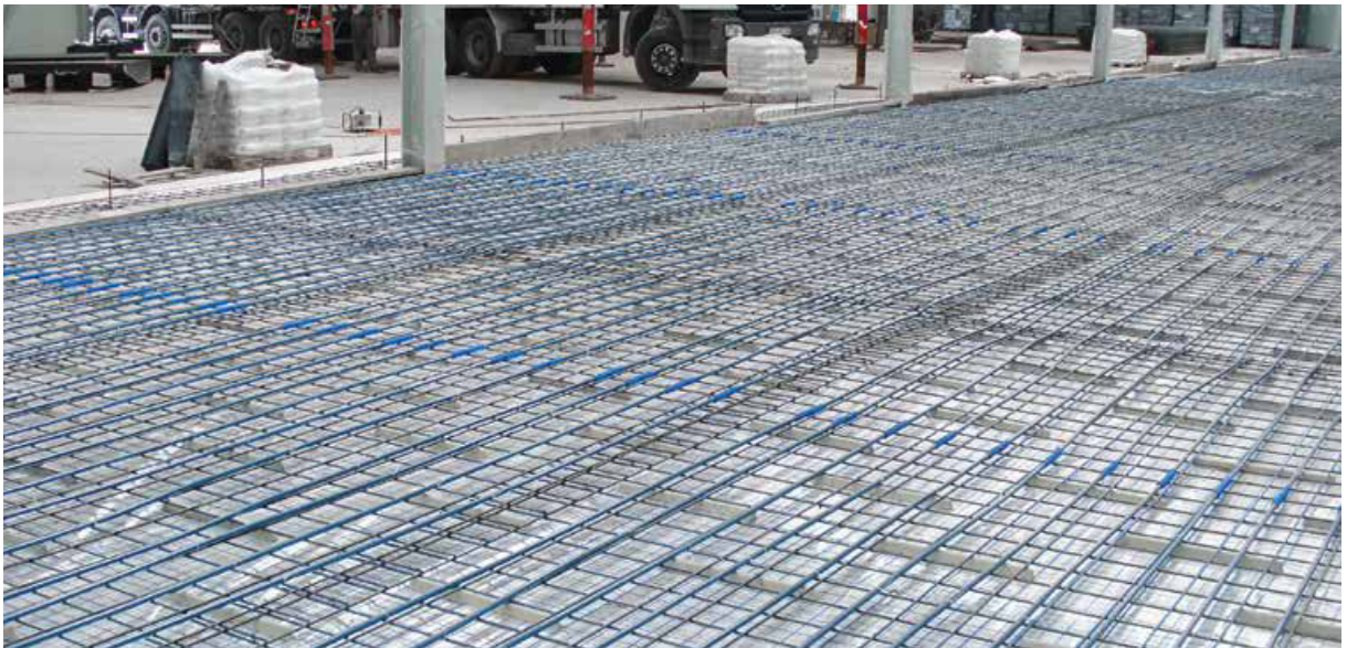
Pav. 4. Grindų šildymo sistema pramoniniame pastate, naudojant bluePERT vamzdžius ir KAN-therm NET sistemą.
